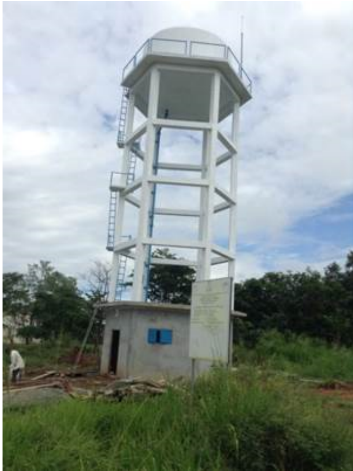
Photo (Green Cross) : Château d'eau au Sri Lanka
