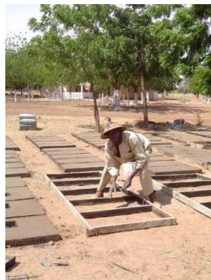
Construction de dalles de latrines en béton, Burkina Faso
